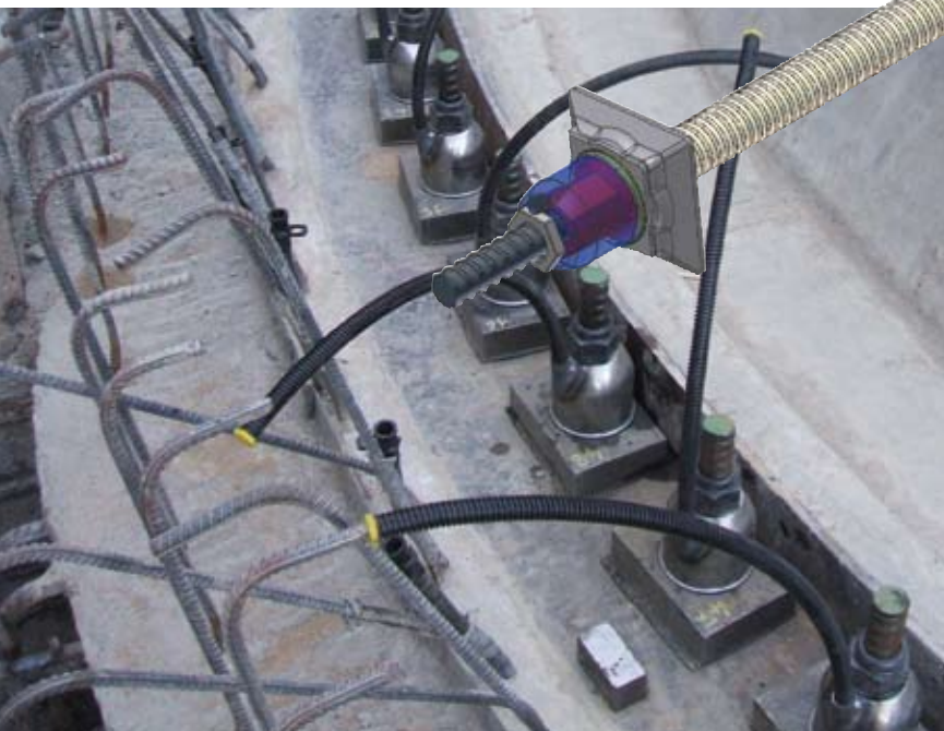
Barre de précontrainte avec adhérence, concept avec plaques QR, plaques pleines rectangulaires et carrées
